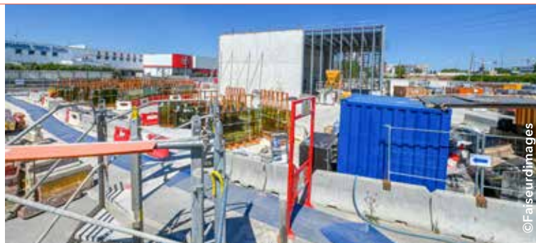
Le chantier de construction de la future station de métro située sur le territoire chevillais, à l'entrée du Min. Signez la pétition pour qu'elle porte le nom de la ville.
