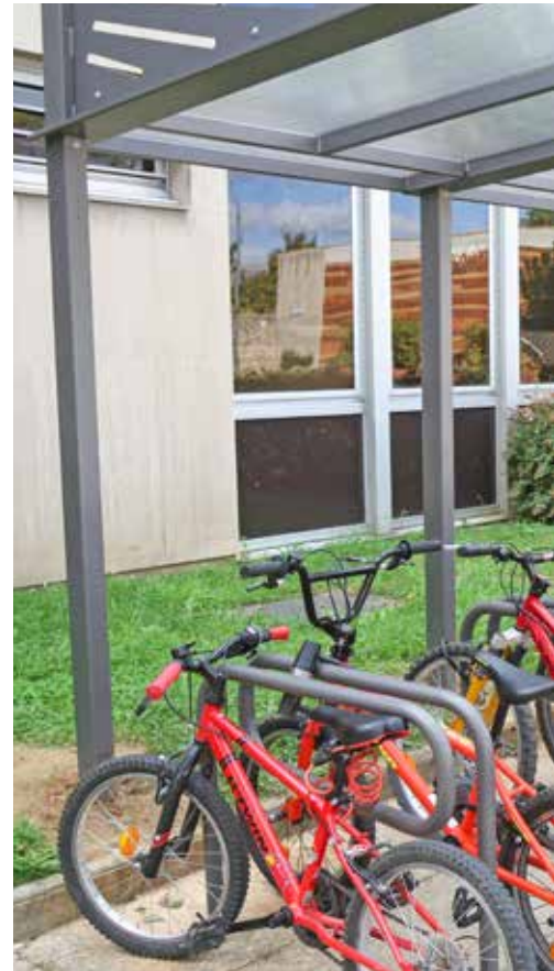
📷 La Ville dispose de 6 abris vélos comportant 8 places chacun.
