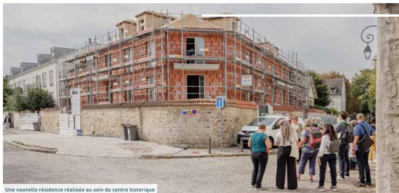
Une nouvelle résidence réalisée au sein du centre historique
