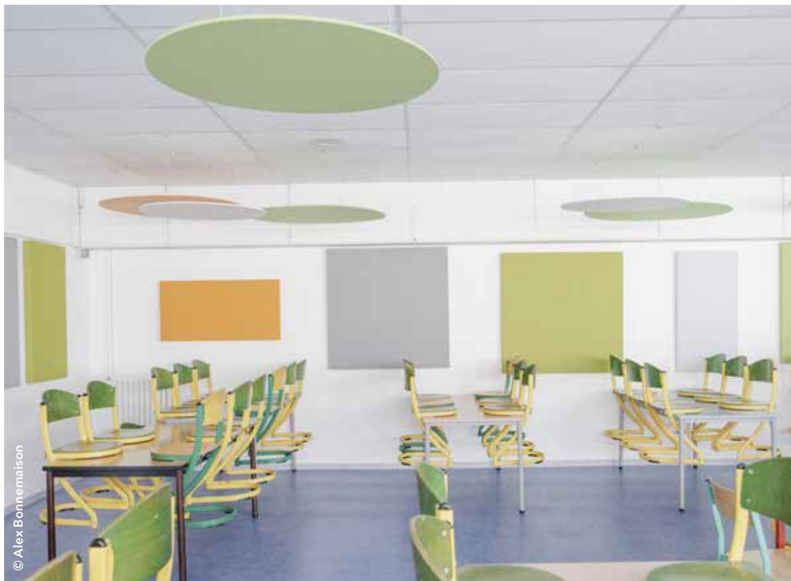
Parmi les chantiers menés cet été dans les écoles, le réfectoire de l'école élémentaire Pierre et Marie Curie a bénéficié d'une rénovation acoustique avec des panneaux posés aux murs et au plafond pour améliorer le confort des élèves et du personnel de l'établissement.
