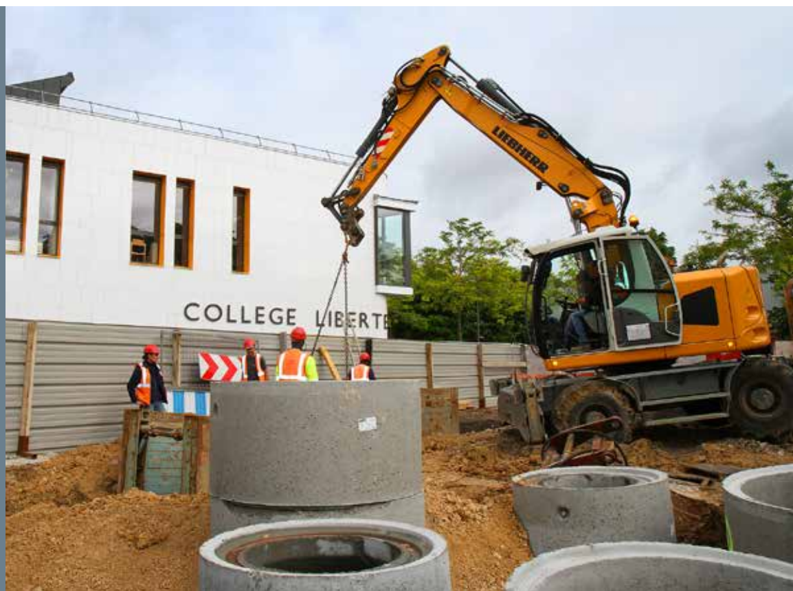
La mise en séparatif des réseaux d'assainissement, une mesure qui favorise l'environnement.
