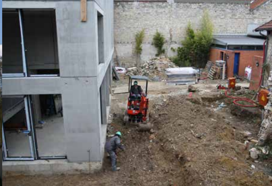
Préparation du terrain en vue de la création d'une terrasse en bois côté cour.
