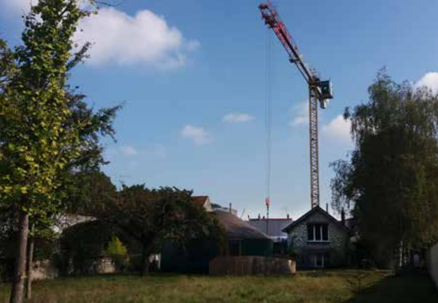
La Maison du Conte bénéficie d'un grand jardin préservé dans le cadre de la réhabilitation.
