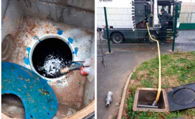
Avant que la cuve puisse être nettoyée, une opération de pompage du fioul a été nécessaire.
