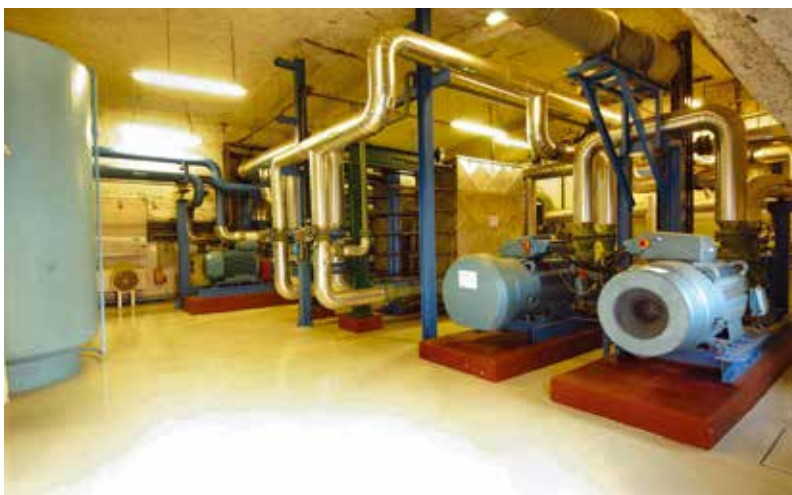
Le réseau de géothermie fait de Chevilly-Larue une ville pionnière en matière de développement durable.
