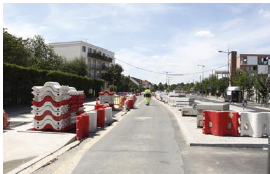
Les travaux de la contre-allée entre la cimetière communal et le carrefour Mermoz sont en passe d'être achevés.
