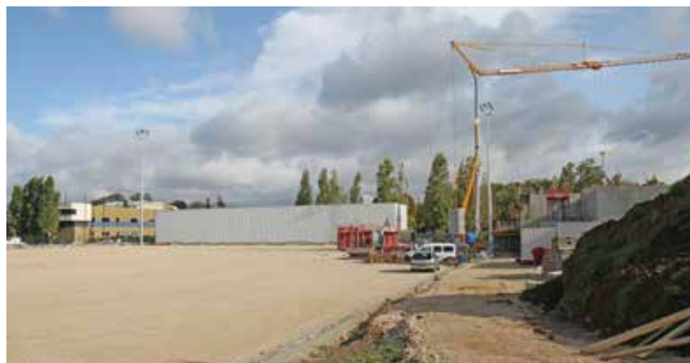
À gauche le futur terrain de rugby, à droite le futur club-house.
