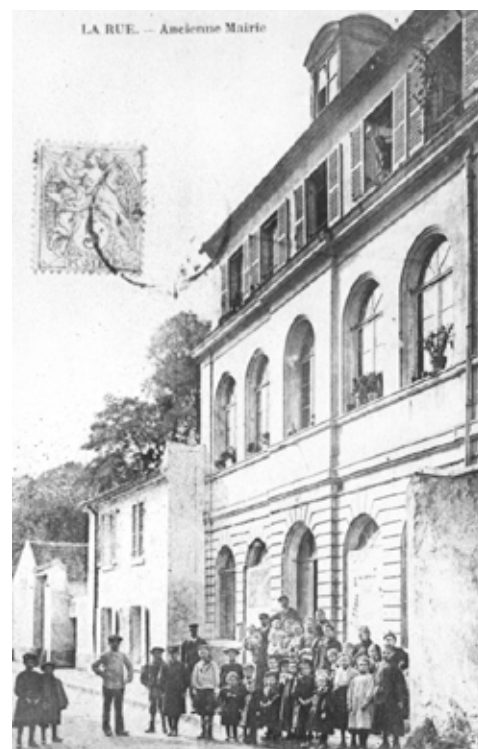
L'ancienne mairie (14 rue Albert Thuret), construite en 1846, qui abrita la bibliothèque de sa fondation, en 1881, à 1895.
