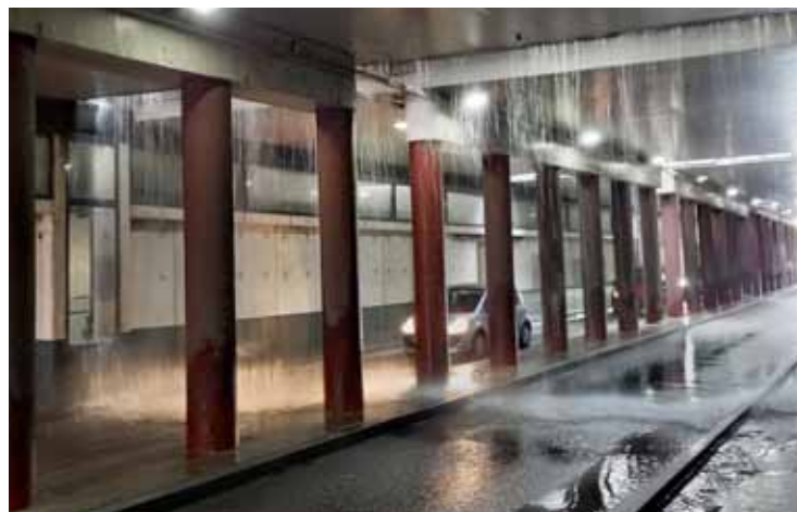
Le pont sur l'avenue du Général de Gaulle. En une heure il est tombé trois semaines de pluie.
