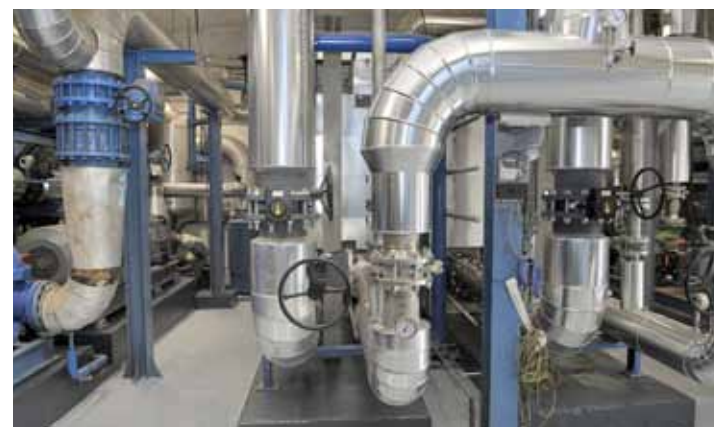
L'extension de la géothermie va permettre d'augmenter la production d'une énergie plus verte.
