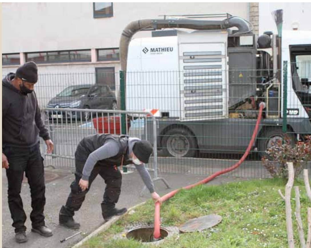
Les agents des Espaces verts puisent l'eau de pluie récoltée dans l'ancienne cuve à fioul enterrée. Cette eau est utilisée au nettoyage des voiries et à l'arrosage.
